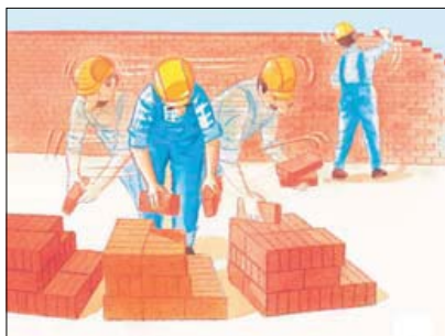
Prelievo dei mattoni da bancali.
