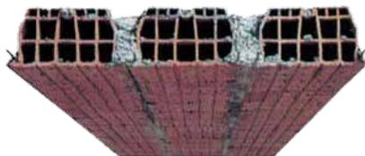
**Solai monodirezionali a lastre "predalles" autoportanti con nervatura gettata (con alleggerimento in laterizio e polistirolo)**
